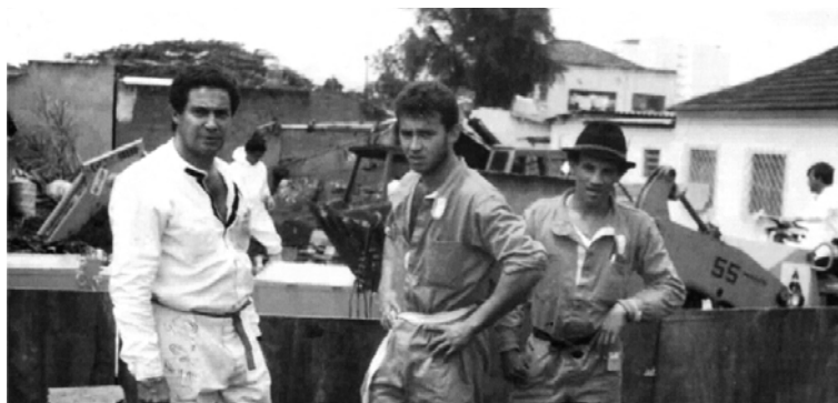
Foto 4: ao lado das obras, os trabalhadores posam para foto sem a proteção devida. Em segundo plano, o operador da máquina junta os escombros das casas na rua 57.
