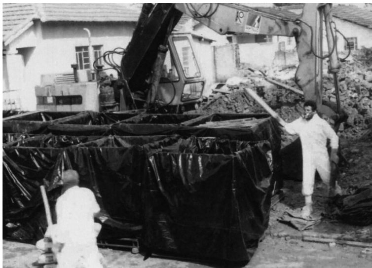
Foto 1: derrubada das casas na Rua 57, onde se iniciou a contaminação. Note-se que os trabalhadores do CRISA estão sem capacete e com trajes inadequados à operação.
